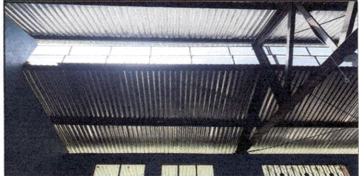
Foto 8: Lámina abollada.
